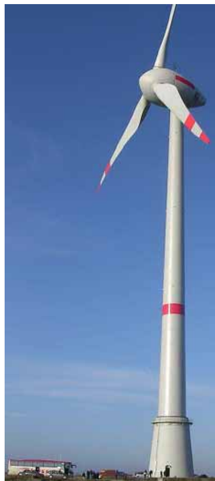
図3 5千kW風力発電機（従来型直接駆動発電機方式，ENERCON社製）写真左下に止まっている大型バスと比較してその大きさがわかる。
