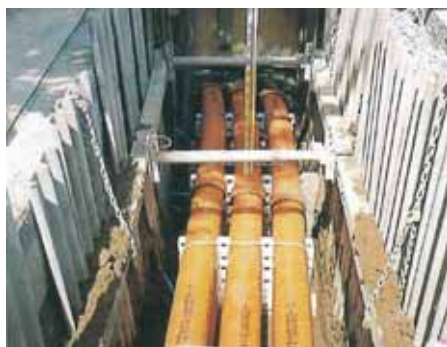
図4 直埋方式の電力ケーブル
