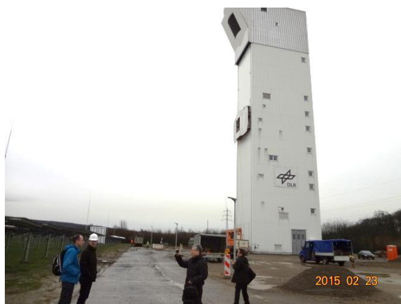
図2 ユーリッヒ太陽熱発電所。改良増強工事が始まっていた。
