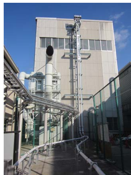
超電導配電システムの外観
