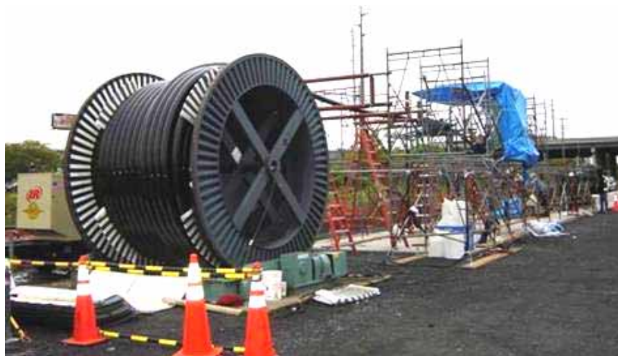
図2 超電導ケーブル布設状況（米国 Albany）
