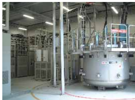
図 1 5MVA-5MJ 瞬低補償 SMES システム
