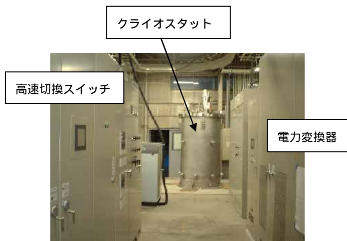
図2 1MVA 瞬低補償 SMES システム
