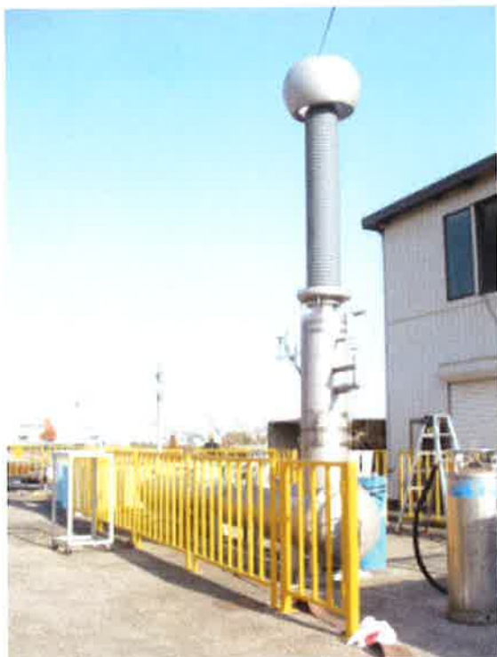
275kV 超電導電力ケーブル用気中終端接続部
